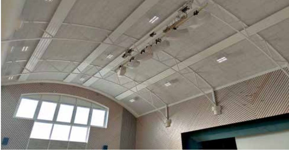
Quelle: Eigenes Foto Neues Dach innen mit Bühnentechnik
