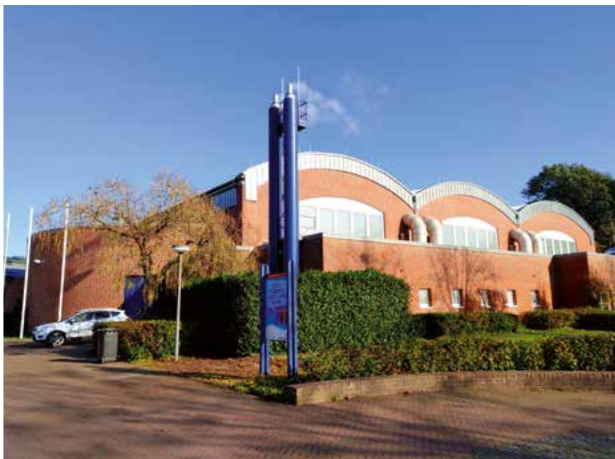
Quelle: Eigenes Foto Energieoptimiertes neues Tonnendach auf der Steverhalle
