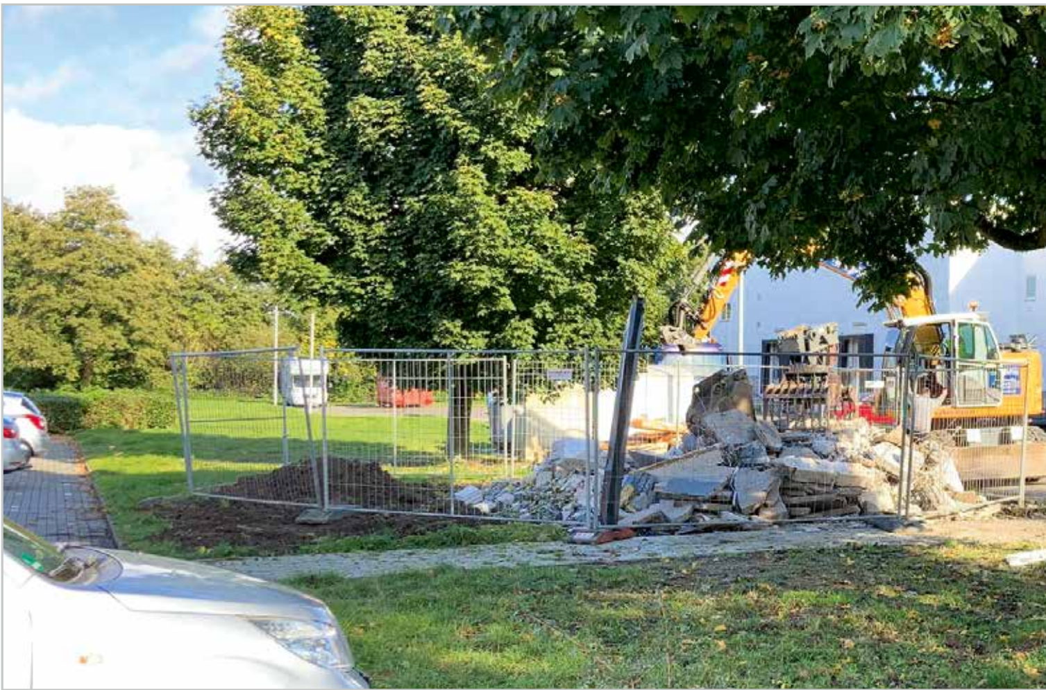
Ein jähes Ende der SB-Filiale: Am 12. Oktober 2021 wird der von der Detonation zerstörte Pavillon am Bösenseller Ortseingang abgerissen
